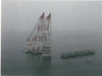
6号函据付 H19.7
