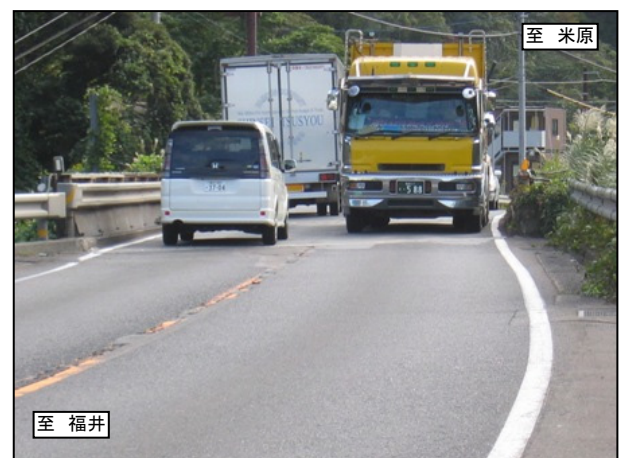
* 「鳩原跨線橋」 はとほら
