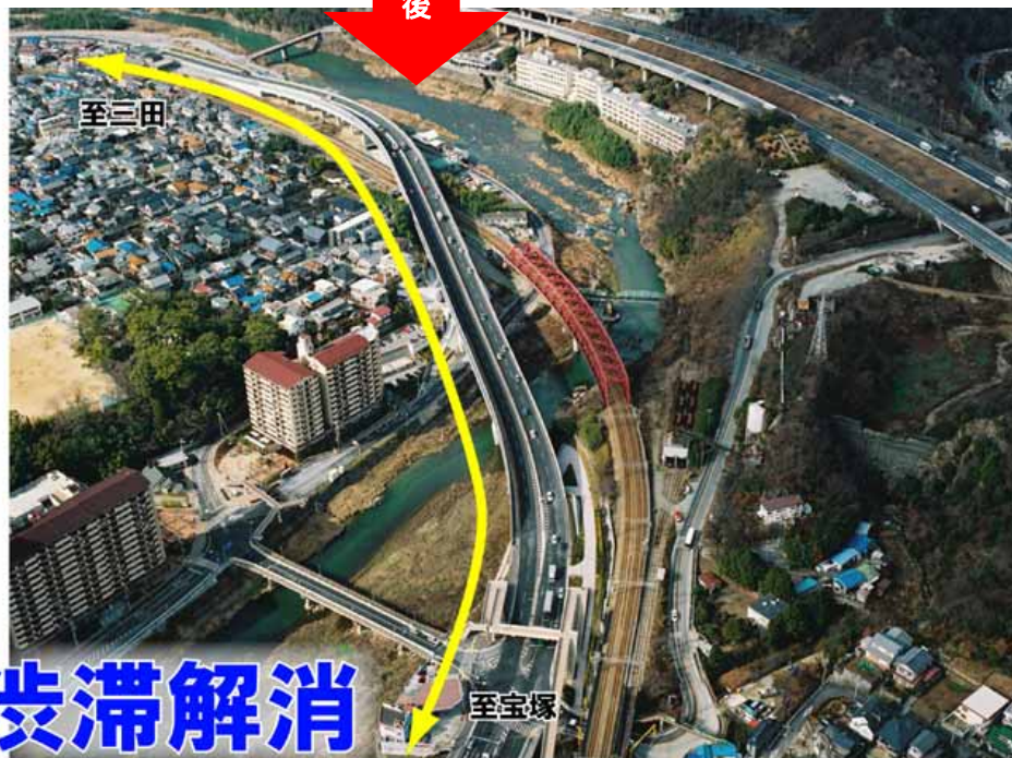
供用後の新生瀬大橋付近
