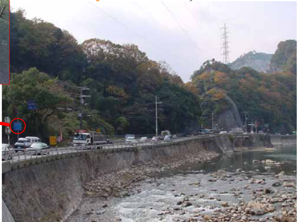
異常気象時通行規制区間 (塩瀬町生瀬～名塩地区)
