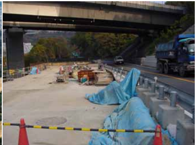
あまこだに 尼子谷 2号橋工事状況(H16.12 撮影)
