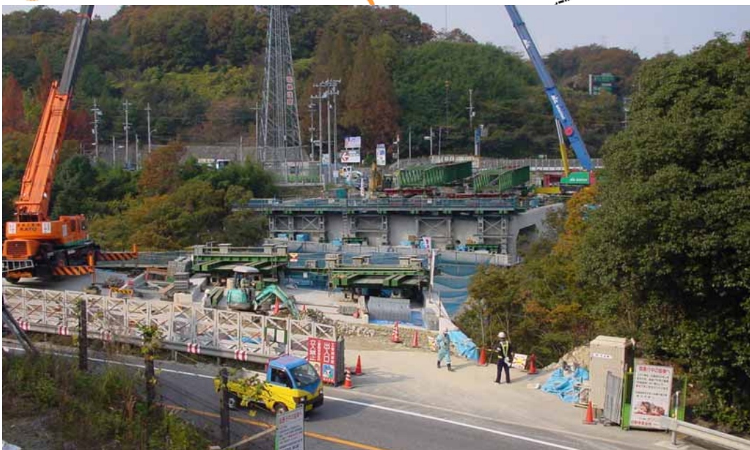
あまこだに 尼子谷 1号橋工事状況(H16.12 撮影)
