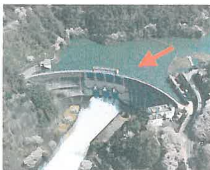
②天ヶ瀬ダム
