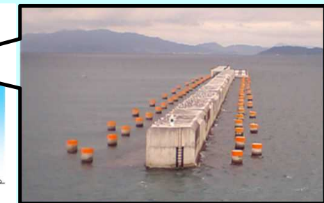
鋼板セル型防波堤
