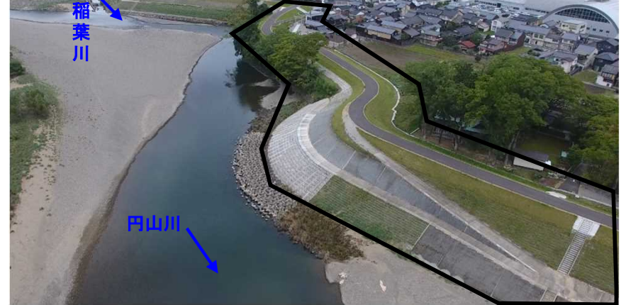
日高地区の一部築堤完了
