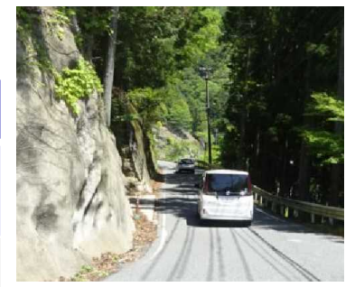
写真 現道狭隘区間 (撮影時期: R5.6)
