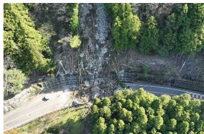
写真① 国道168号崩土状況(撮影時期: R5.4)
