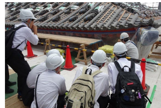
東楼工事の現場見学会の様子
