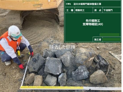
写真2 地中内に点在していた巨礫
