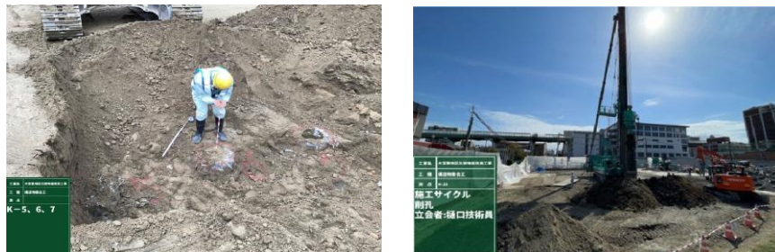
写真1 基礎杭の除去の施工状況
