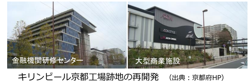
■京都府域の開発状況 (桂川・宇治川・木津川下流沿川)
