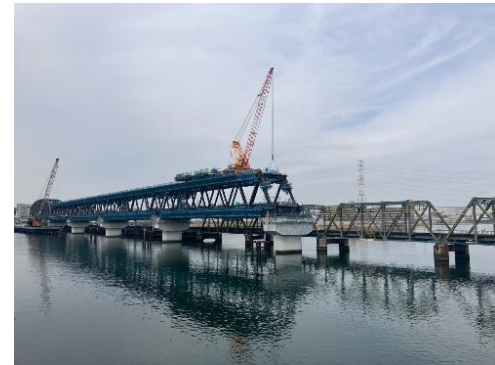
写真3 トラベラー・クレーンによる桁架設状況
