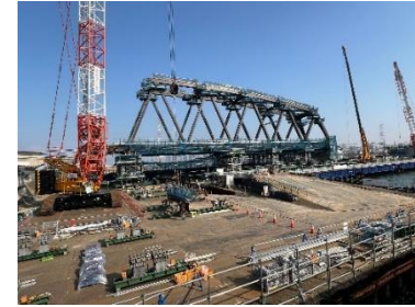
写真5 施工ヤードの状況
