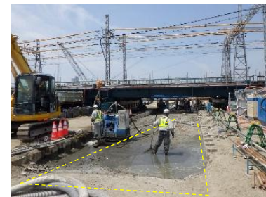
写真4 地盤対策工の追加
