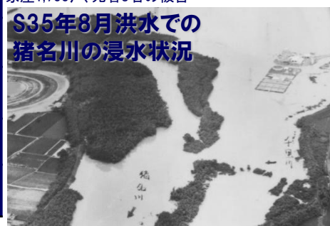
S35年8月洪水での 猪名川の浸水状況 猪名川の堤防が伊丹市口酒井地区で30mにわたって決壊し、多数の家屋に床上浸水の被害
