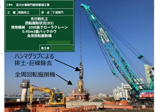
写真1 全周回転掘削機を用いた先行掘削
