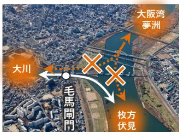
閘門設置前の淀川大堰周辺
