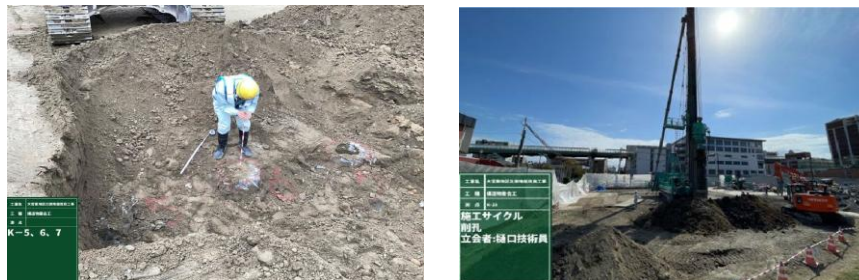
写真1 基礎杭の除去の施工状況
