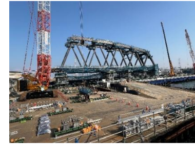
写真5 施工ヤードの状況
