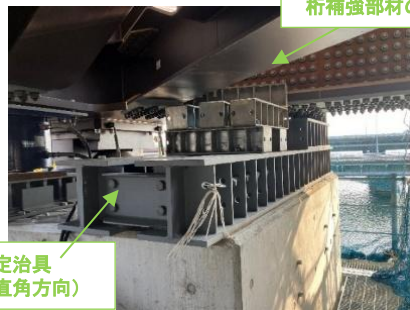
写真2 桁補強部材・固定治具の追加
