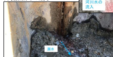
写真2 床堀面からの漏水
