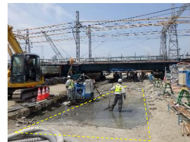
写真4 地盤対策工の追加
