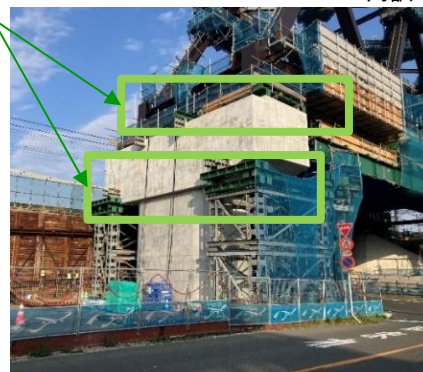
写真1 ベント転倒防止設備（P46橋脚）
