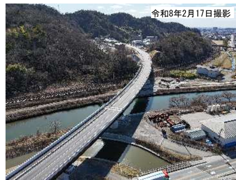
写真① 【米原バイパス（9工区）】
