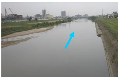
下流域のコンクリート護岸
