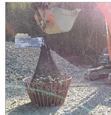
水制工に改修事業の発生材を利用
