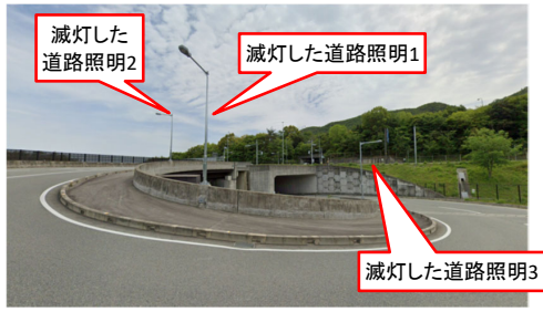
事故状況写真③ 被害状況
