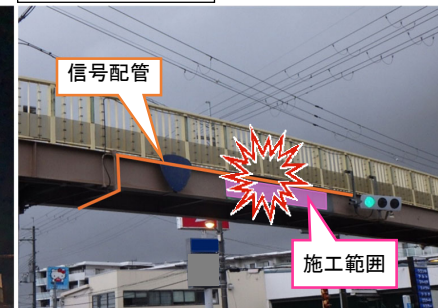
事故状況写真②
