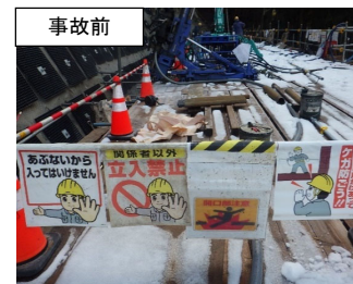
立入禁止標識の設置状況(開口部から遠い) 合図確認標識の設置状況(標識のみ)
