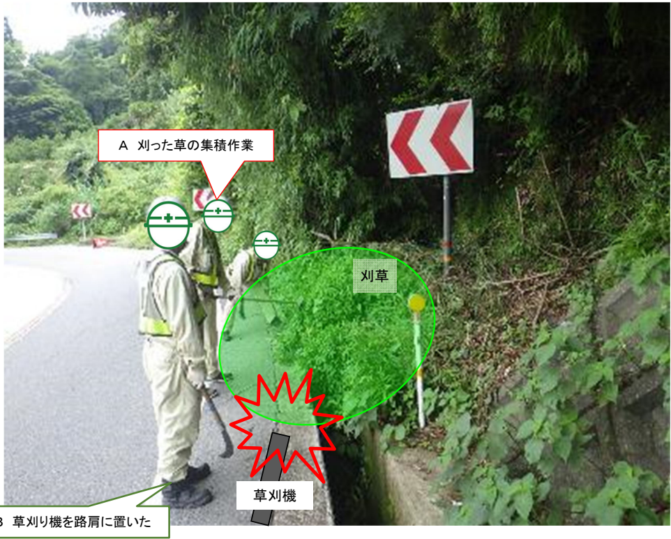
事故状況写真
