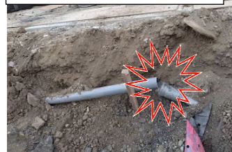
事故状況写真③ 破損した地下埋設管(塩ビ管φ75)
