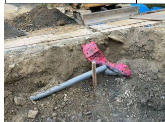
事故状況写真③ 破損した地下埋設管(塩ビ管φ75)
