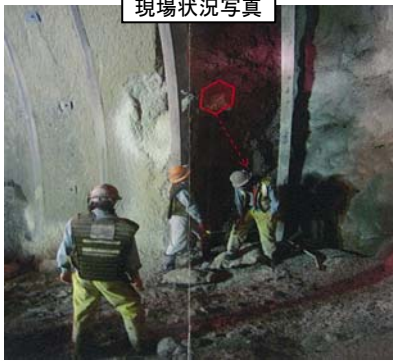
現場状況写真
