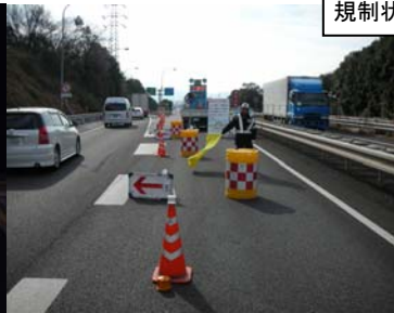
規制状況写真
