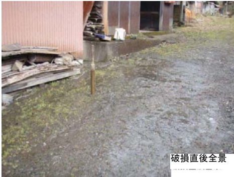
事故現場写真
