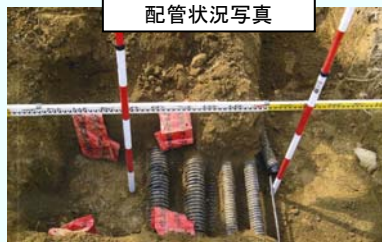
配管状況写真
