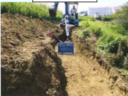
施工状況写真
