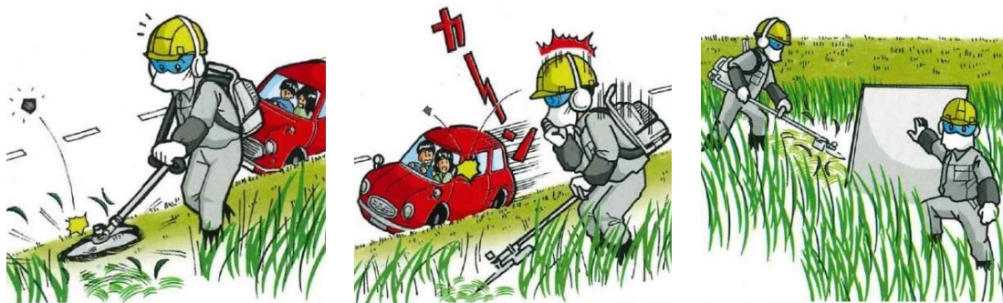
図 1.22 道路付近での除草作業と飛石事故及び防護パネルの利用
