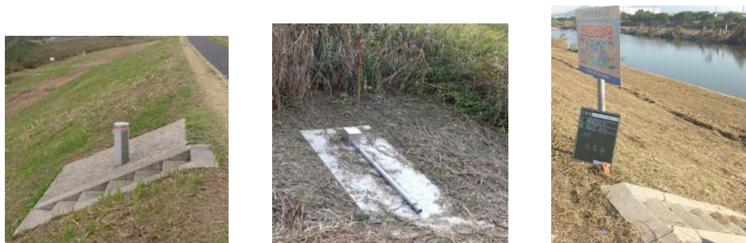
写真 2.5 河川堤防内にある構造物の例 (左から、距離標、水位計、看板と階段)
