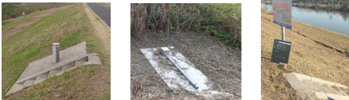
写真 1.2 河川堤防内にある構造物の例 (左から、距離標、水位計、看板と階段)
