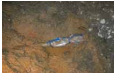
破損部 復旧後
