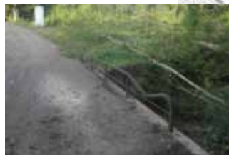
現場状況写真③
