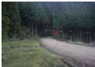
現場状況写真②
