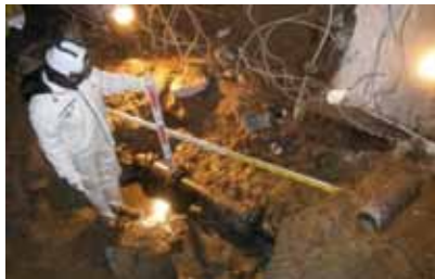
破損部 復旧後
