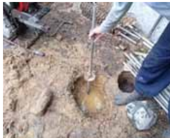
破損した水道管 (死管でエンドキャップが付いていた)
