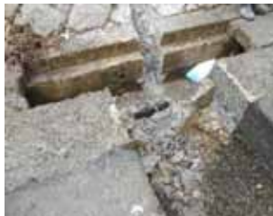
管路破損時状況 (作業断水時)
