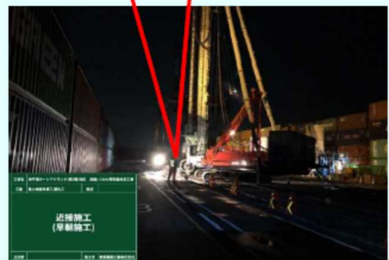
機械攪拌近接施工(早朝施工)
