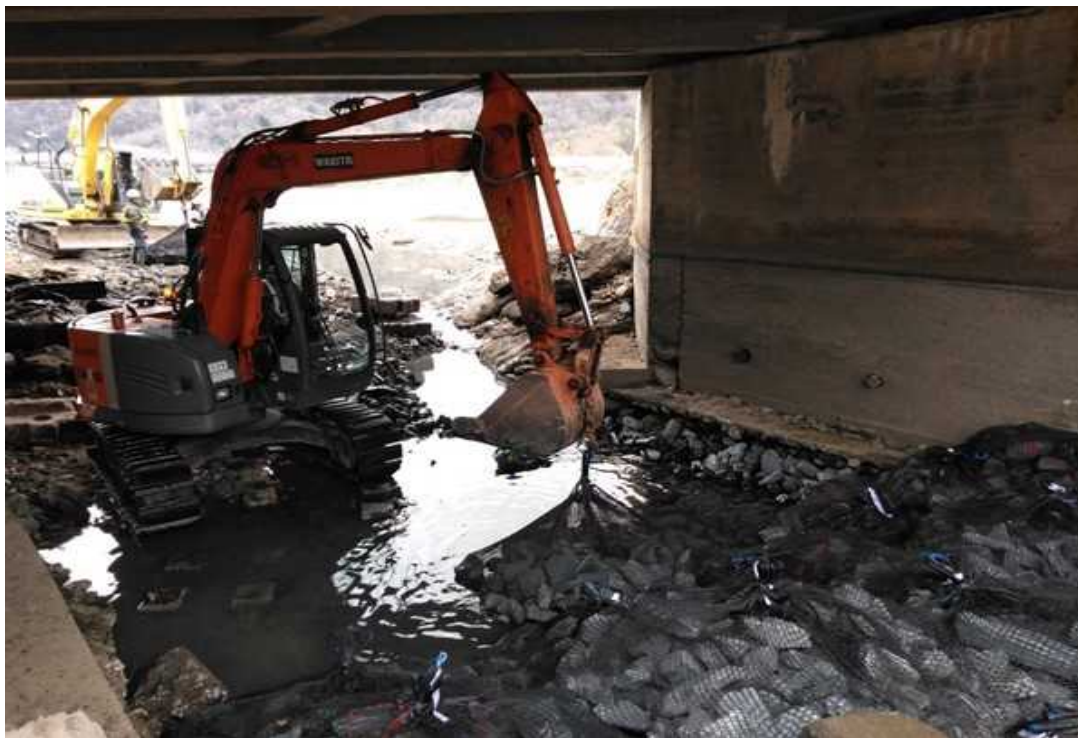
洗堀された条件護岸(河床)の応急復旧工事(宮川橋)
