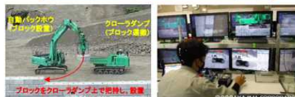
ブロック設置作業状況
