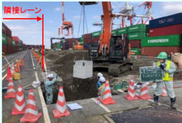
集水桝改良近接施工(荷役休止日施工)
