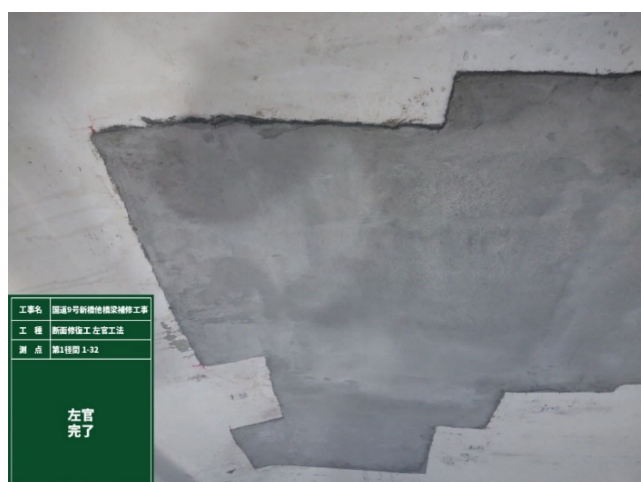
桁下面 施工完了(ポリマーメント)
