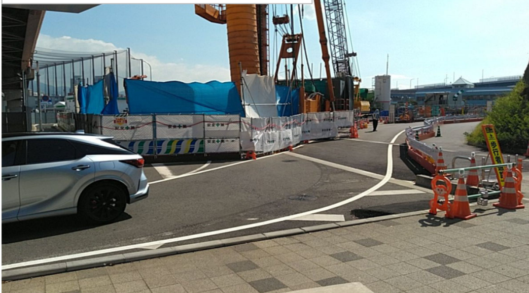
施工中(R6.8)神戸震災復興記念公園付近
