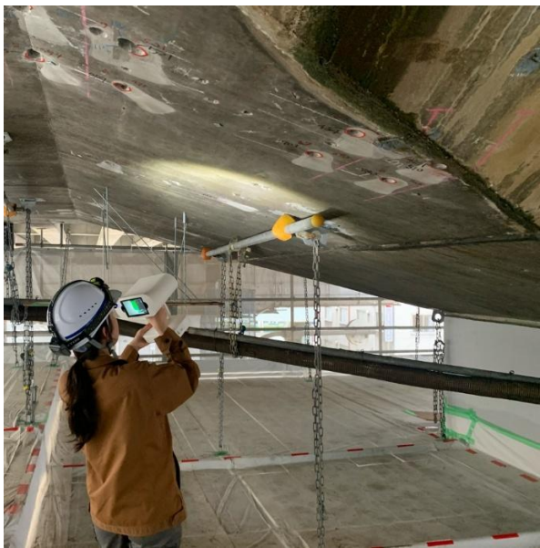
コンクリート削孔完了後のアンカー位置をワイヤレス ハンディスキャナーを用いて高精度で計測
