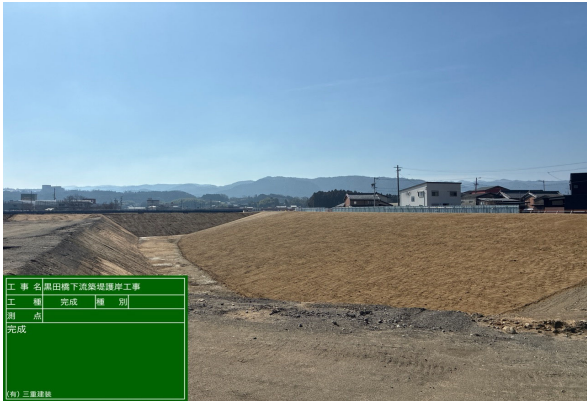
■黒田地区引堤区間 築堤・護岸 L=80m (完成)
