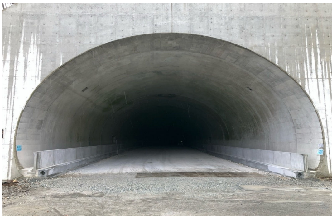
大野油坂道路大谷トンネル内の排水構造物工および監視員通路工
