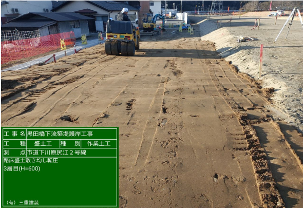
■黒田地区引堤区間 付帯道路 (排水構造物、付帯道路の施工状況)
