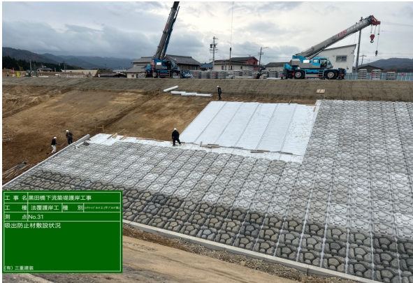
■黒田地区引堤区間 築堤・護岸 L=80m (平ブロック張の施工状況)
