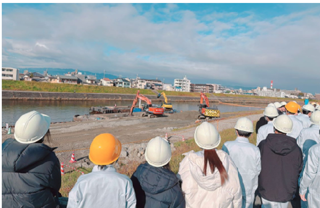
地元高校生への工事(浚渫)見学会の様子
