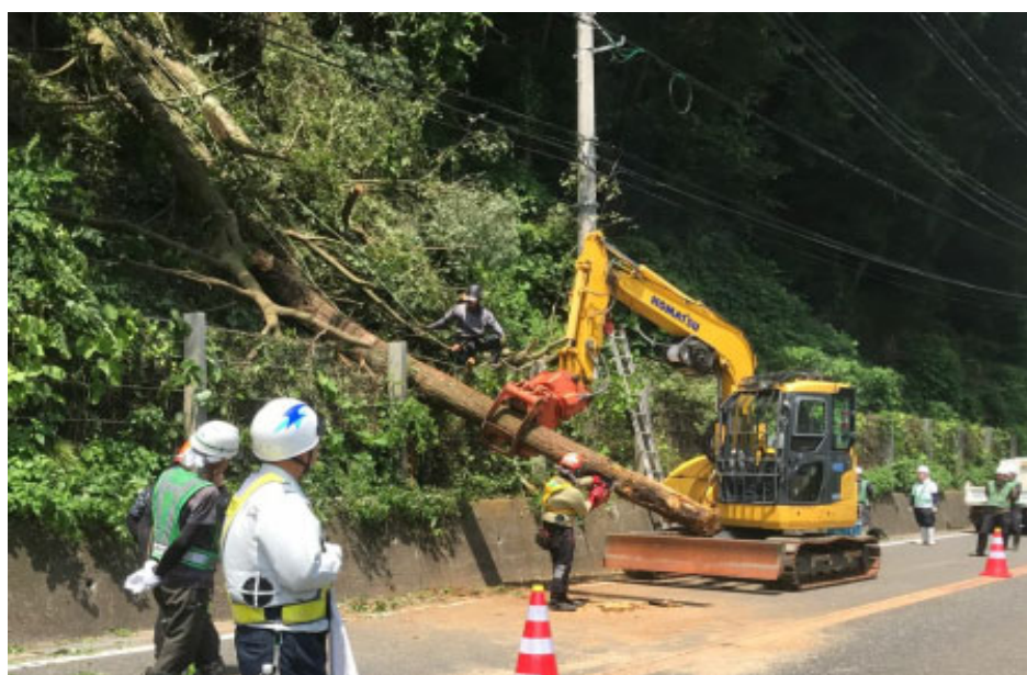
通行止めを伴う倒木について、緊急出動して倒木の切断・撤去を行い、早期に交通規制解除を行った。
