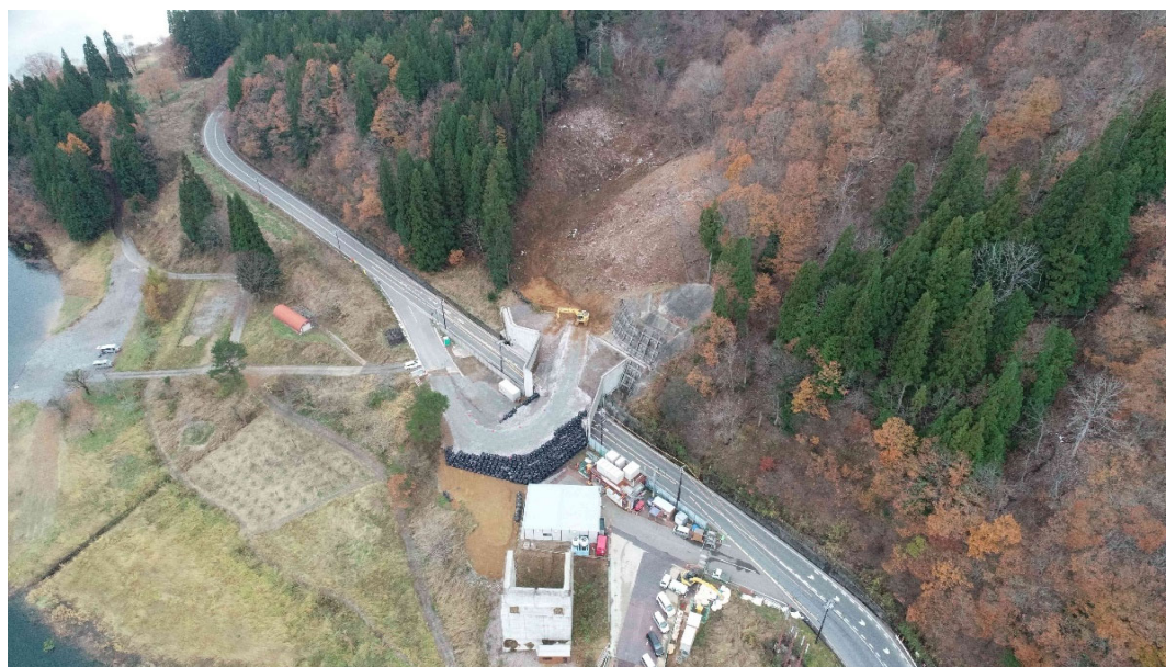
伐採および工事用道路の造成
