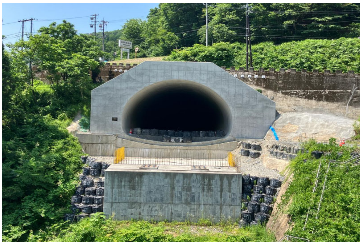
終点側坑口部
