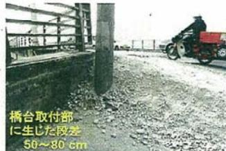
橋台背面盛土の沈下の事例
