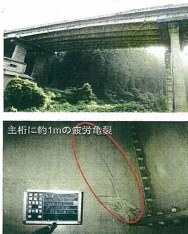
▲主桁の疲労亀裂の事例
