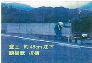
橋台背面盛土の沈下による段差及び踏掛版の損傷の事例
