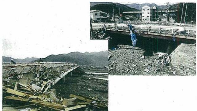
▲上部構造の高さに津波の遡上の痕跡があるが、流出していない橋
