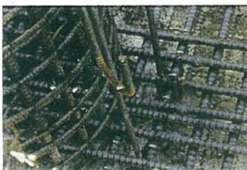
▲杭頭補強鉄筋とフーチング鉄筋の干渉(過密配筋)
