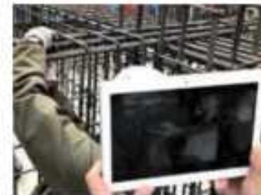
Webカメラを利用した遠隔検査
