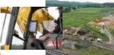
3次元設計データ等により、ICT建設機械を自動制御し、建設現場のICT化を実現。
