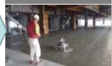
ケーブル配線用延線ロープ敷設ロボット
