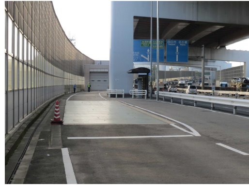
車両重量計設備の事例
