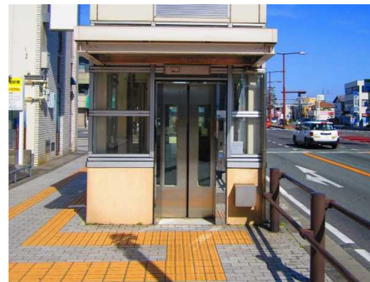
道路用昇降設備の事例
