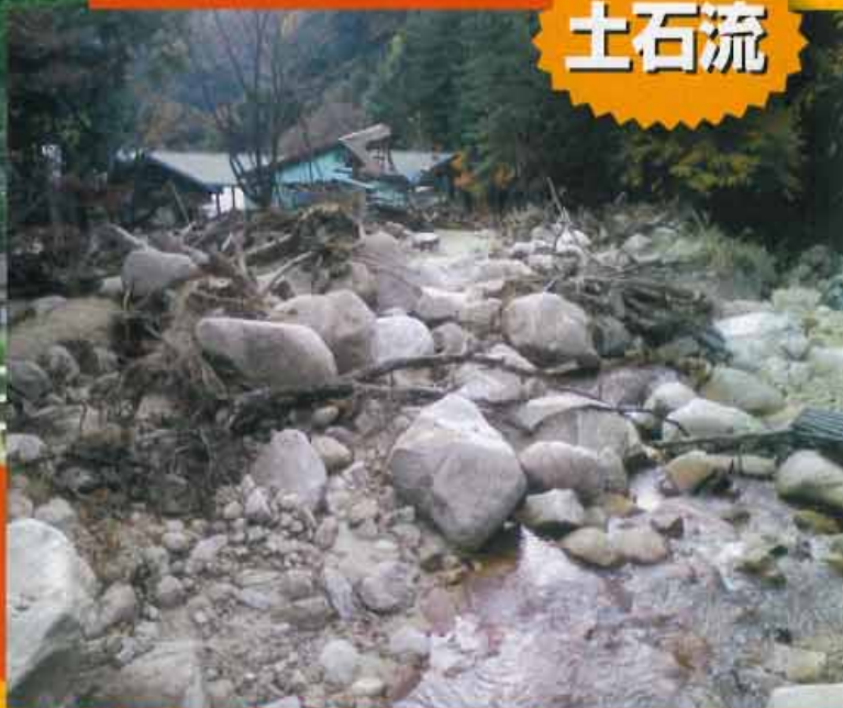
三重県四野町 (平成20年9月2日発生)
