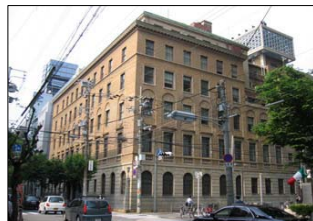
綿業会館（重要文化財）
