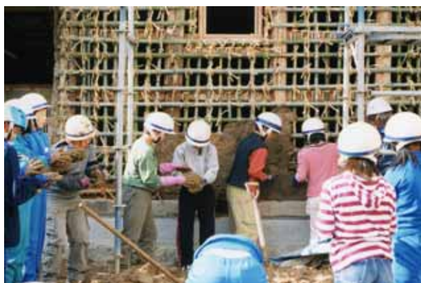
建造物の修繕活動と技術伝承
