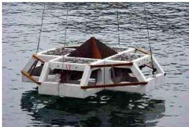
図 1-58 設置された攪拌ブロック礁（岸和田市地先）
