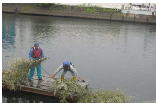
粗朶沈床設置
