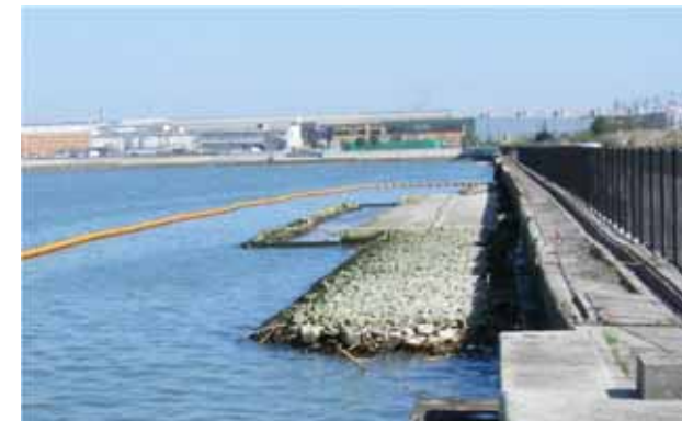
生物共生型護岸(堺2区)
