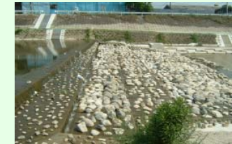
瀬と淵浄化施設(檜井川)
