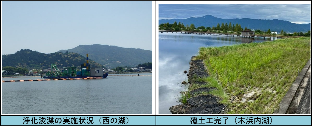
■河川浄化浚渫・覆土実施状況
