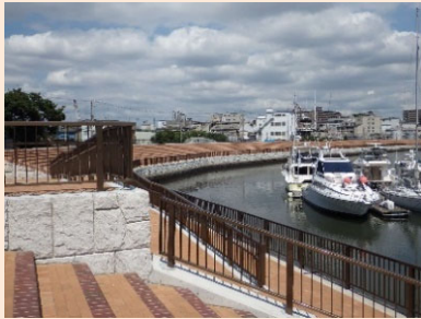
整備した親水護岸の例
