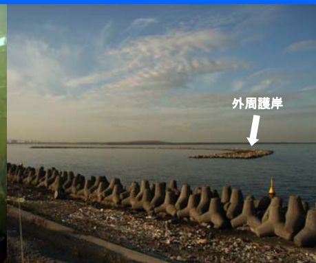
堺泉北港堺第2区人工干潟(造成中)
