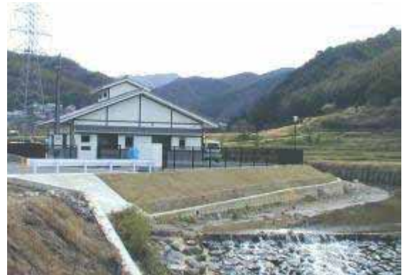
写真 4-4 集落排水施設 (奈良市)
