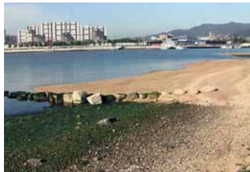
写真 4-14 造成した浅場（御前浜水環境再生実証実験施設）
