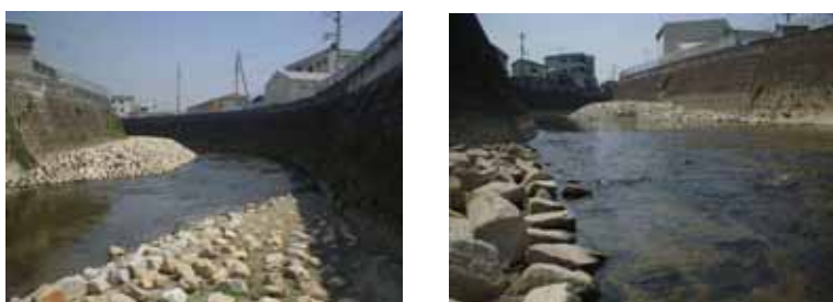
写真 4-5 東除川 薄層流浄化施設
