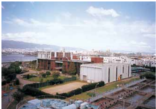
武庫川下流浄化センター 外観
