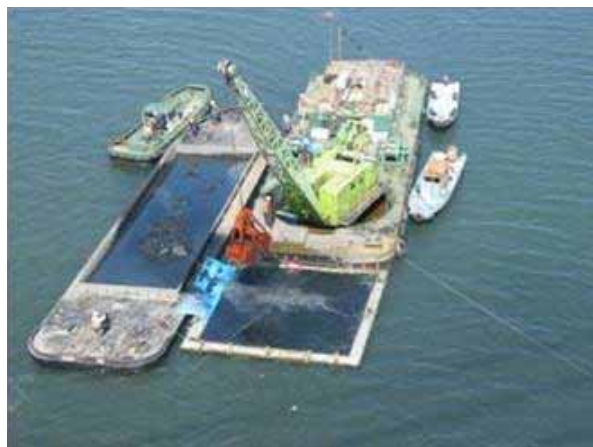
写真 4-10 底質浄化対策の試験施工（イメージ）
