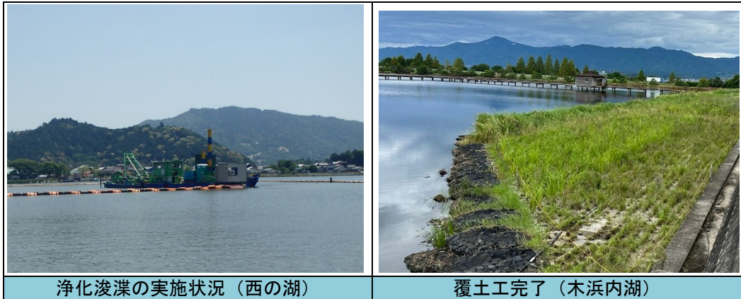
■河川浄化浚渫・覆土実施状況
