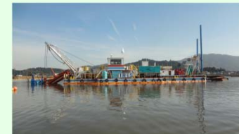
浄化浚渫の実施状況(西の湖)
