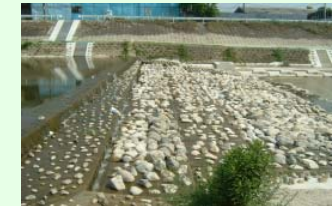
瀬と淵浄化施設(樫井川)
