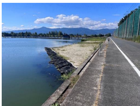
図 11 覆土工の実施状況（木浜内湖）
