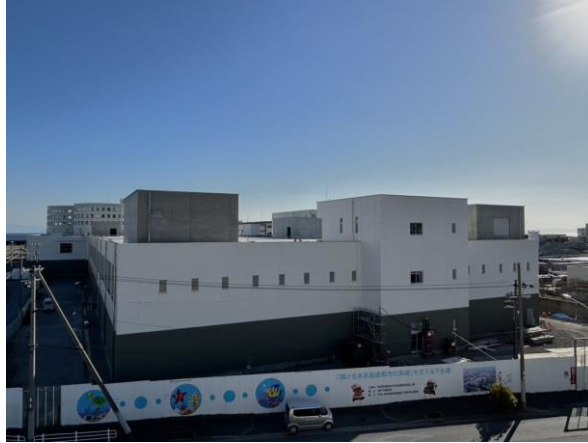
西部北系 写真提供：神戸市 図 4 高度処理施設
