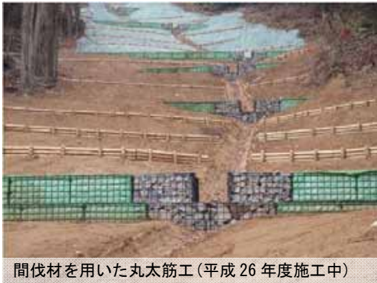
間伐材を用いた木製校倉式土留工(平成 26 年度施工中)
