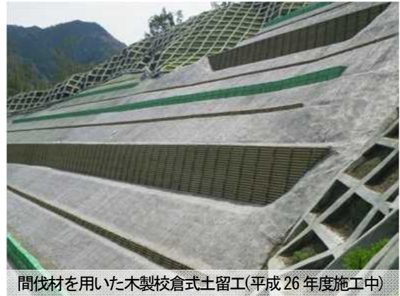
間伐材を用いた丸太筋工(平成 26 年度施工中)
