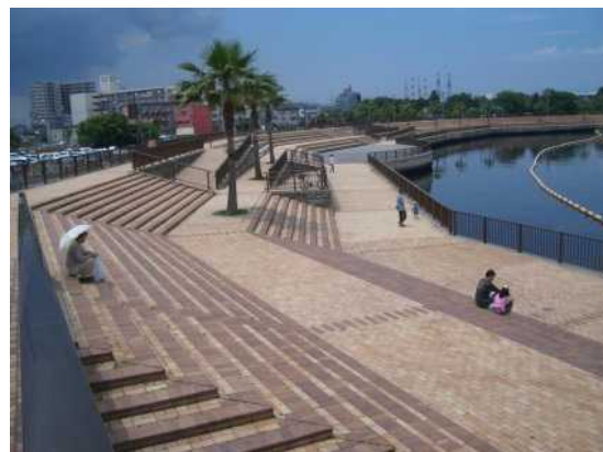
図 1-31 整備した親水護岸（堺旧港）
