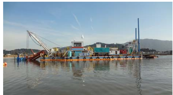
浄化浚渫の実施状況（西の湖）
