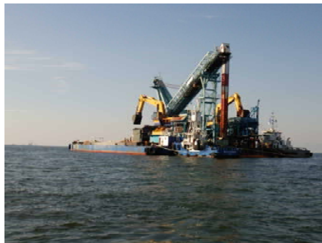
図 1-47 窪地の埋め戻しの状況（阪南 2 区沖窪地）
