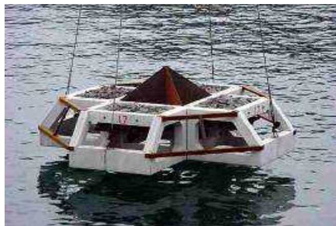
図 1-49 設置された攪拌ブロック礁（岸和田市地先）
