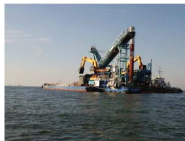
窪地の埋め戻しの状況 (阪南2区沖窪地)
