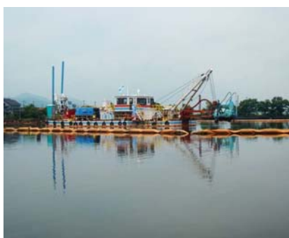
浄化浚渫の実施状況（西の湖）
