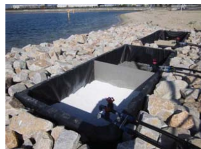
浄化材を用いたタイドプール （堺浜）
