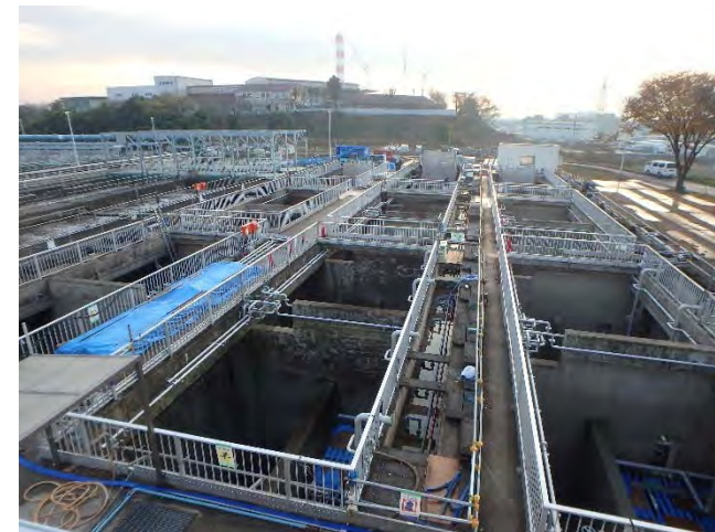
整備中の伏見水環境保全センター 高度処理施設
