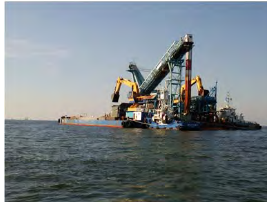
窪地の埋め戻しの状況 (阪南2区沖窪地)
