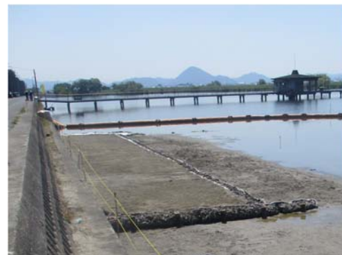
覆土工完了（木浜内湖）
