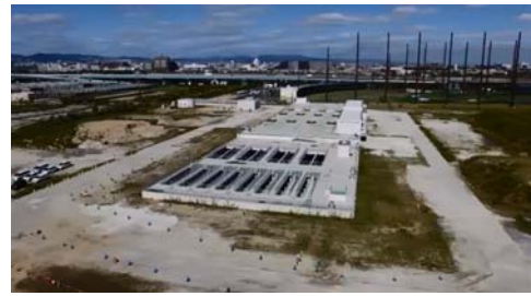
西宮市甲子園浜浄化センター
